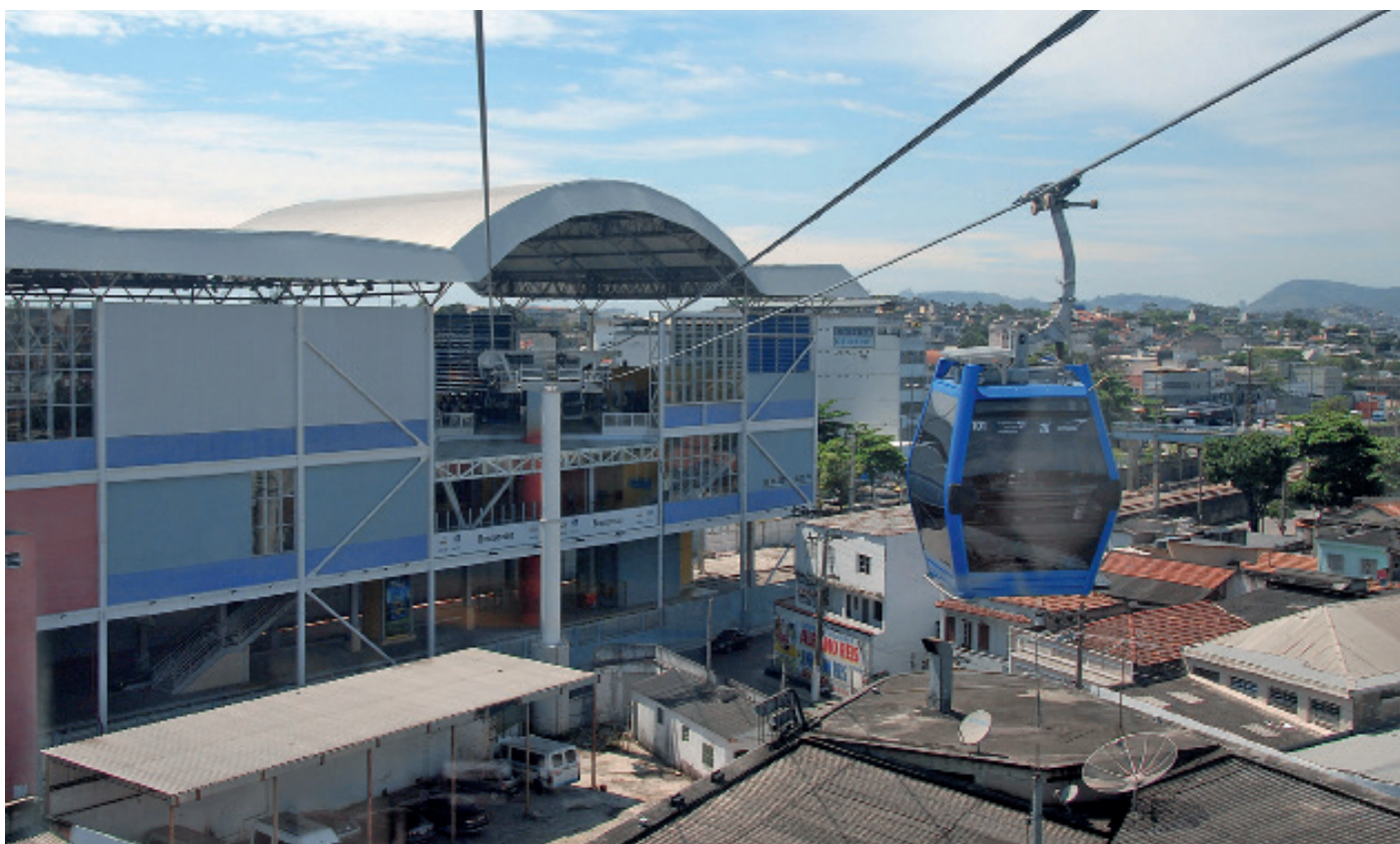
Anschluss der Kabinenbahn „Alemão“ an eine Schnellbahnstation in Rio de Janeiro
